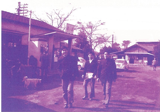
鶴ヶ島駅付近 舗装してなくて雨の日は泥だらけ
