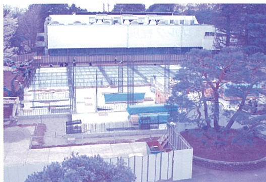
「ロータリー近くで工事が進んでいます」
